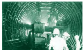
【シールド工法(旧B滑走路地下トンネル)】
