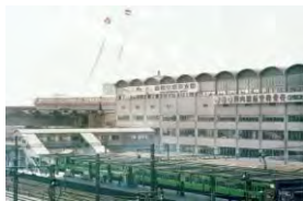
【国鉄浜松町駅とを結ぶ跨線橋(1966年)】
