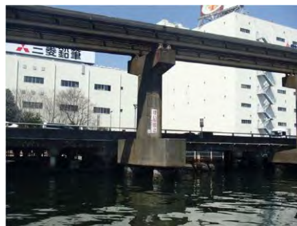
〔耐震補強工事前〕
