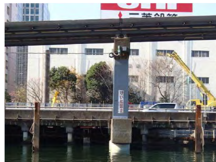
〔耐震補強工事後〕
