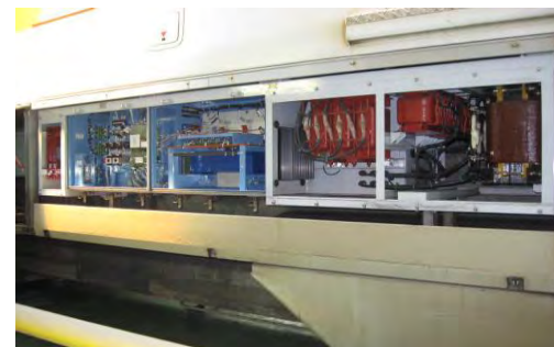
〔補助電源装置〕
