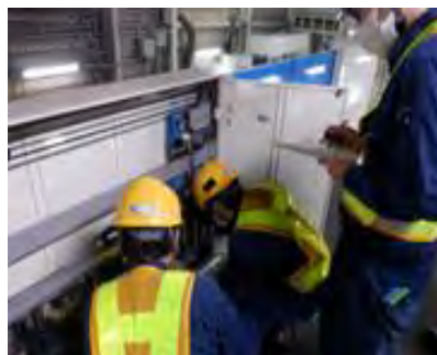
〔可動式安全柵取扱訓練〕
