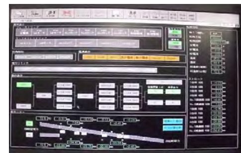
〔ポイント常時監視システム〕
