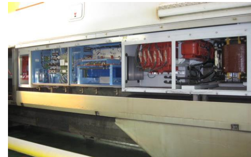
〔補助電源装置〕
