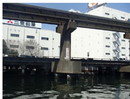
〔耐震補強工事前〕
