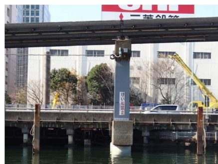
〔耐震補強工事後〕
