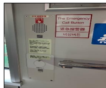
〔非常通報装置〕
