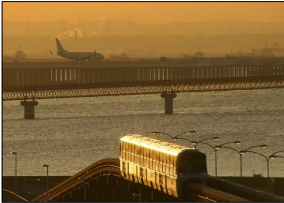
〔空港トンネル付近〕
