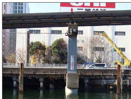
〔支柱耐震補強工事後〕
