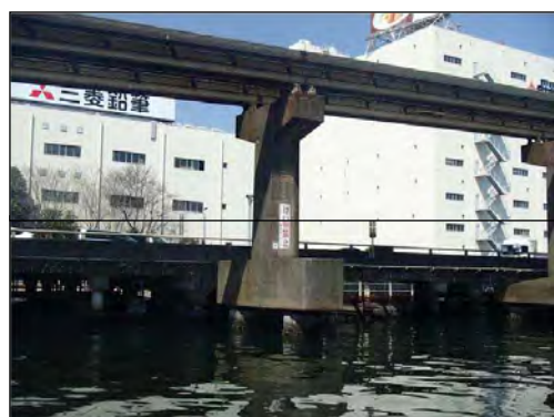
〔支柱耐震補強工事前〕
