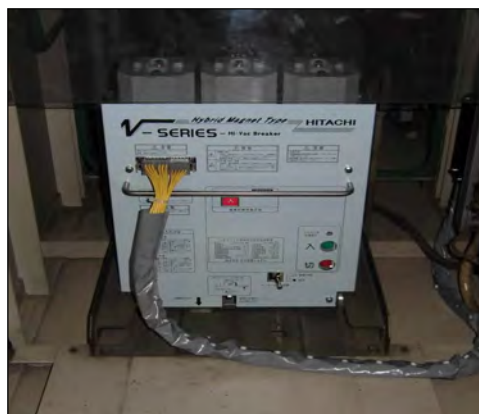
〔配電室遮断器更新〕
