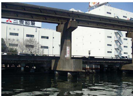
〔支柱耐震補強工事前〕
