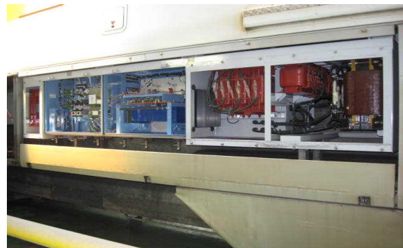
〔補助電源装置〕
