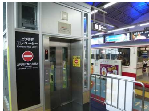
〔5階乗車ホームエレベーター (3階から)〕
