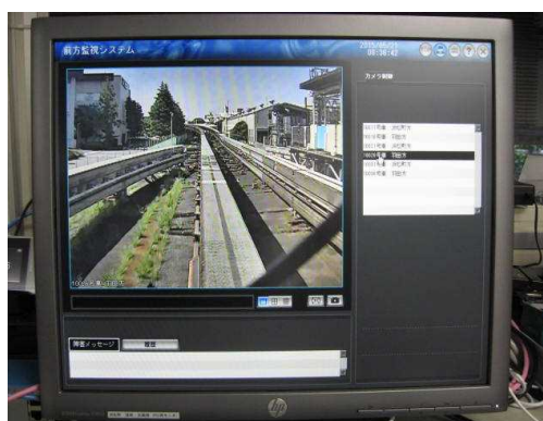
〔地上側モニタ装置〕
