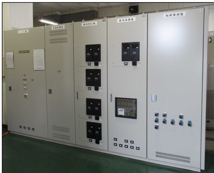
〔変電所制御装置〕
