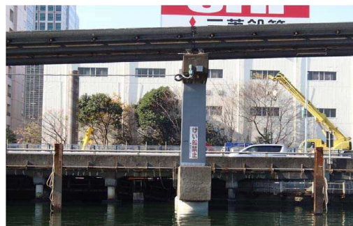
〔支柱耐震補強工事後〕
