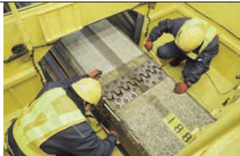
工作車を使用した軌道設備の点検
