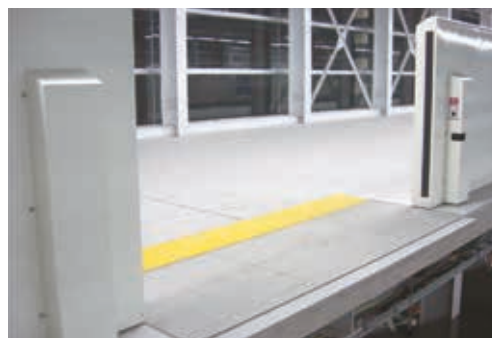
隙間への足の踏み外しや転落を防止する可動ステップ
