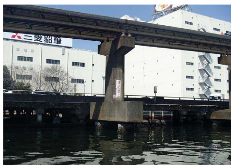
〔支柱耐震補強工事前〕
