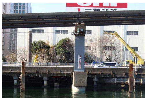
〔支柱耐震補強工事後〕
