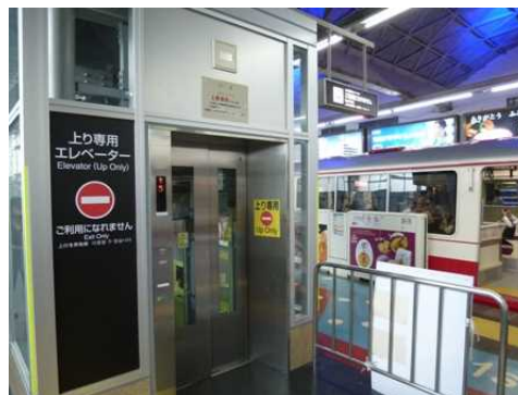
〔5階乗車ホームエレベーター (3階から)〕
