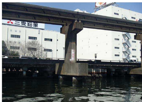
〔支柱耐震補強工事前〕
