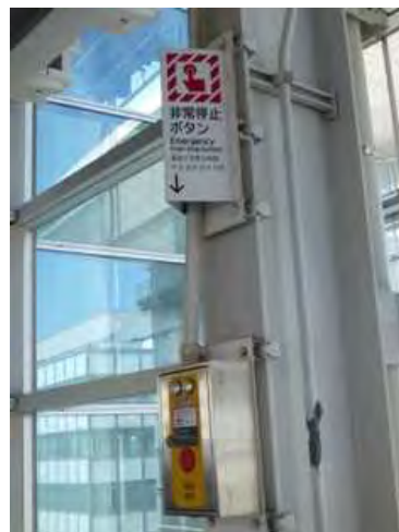
〔非常停止ボタン〕
