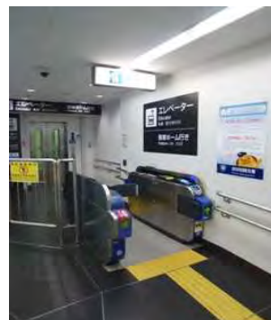
〔3階エレベーター（中央口）〕
