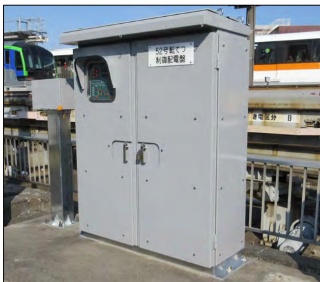
〔車庫内転てつ器制御配電盤〕
