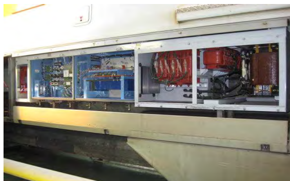
〔補助電源装置〕
