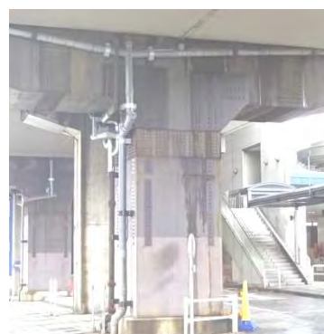
〔天王洲アイル駅耐震補強工事後〕
