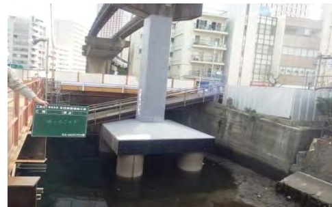
〔支柱耐震補強工事後〕
