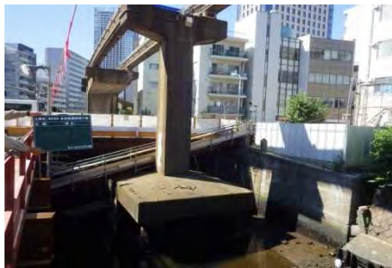
〔支柱耐震補強工事前〕
