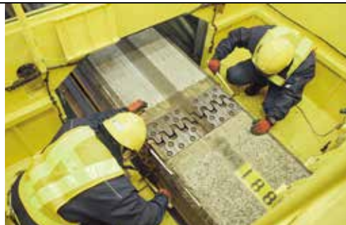
工作車を使用した軌道設備の点検
