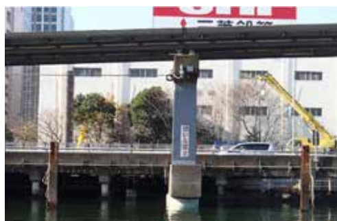
耐震補強工事を実施した支柱
