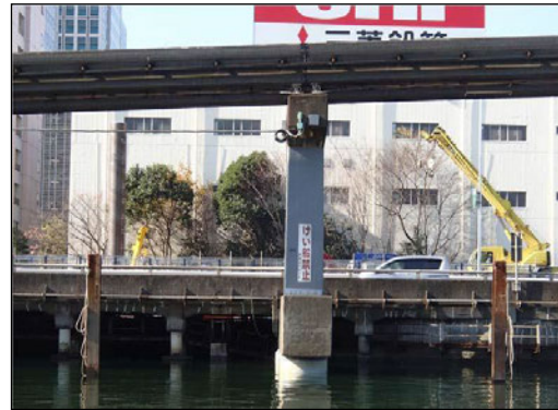
〔耐震補強工事後〕
