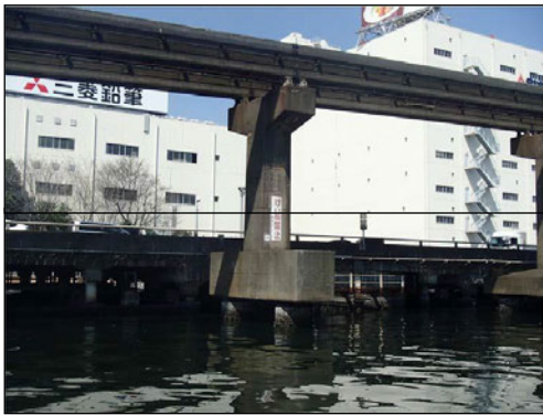
〔耐震補強工事前〕
