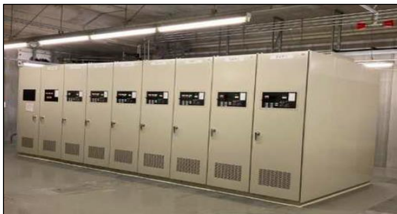
[変電所直流高速度遮断器更新]
