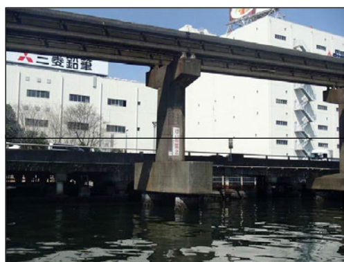
〔耐震補強工事前〕
