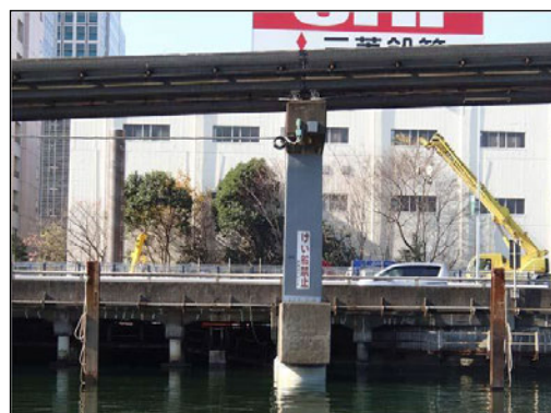
〔耐震補強工事後〕
