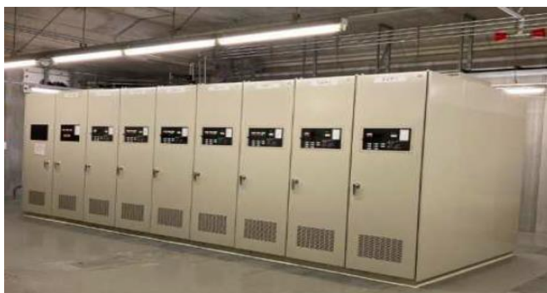
〔変電所直流高速度遮断器更新〕
