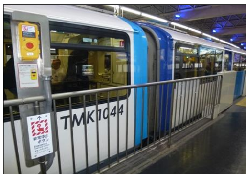
〔非常停止ボタン設置駅〕
