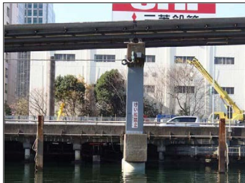
〔支柱耐震補強工事後〕
