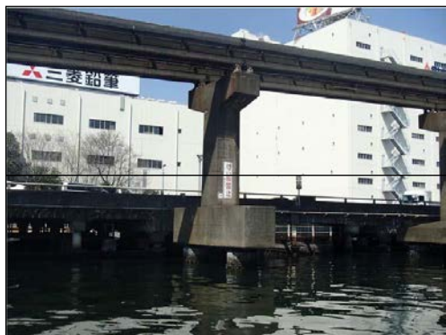
〔支柱耐震補強工事前〕
