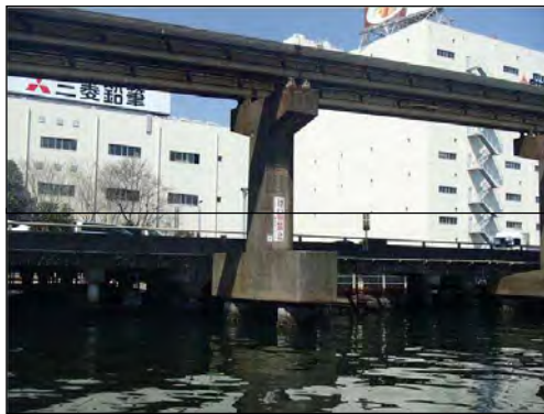
〔支柱耐震補強工事前〕
