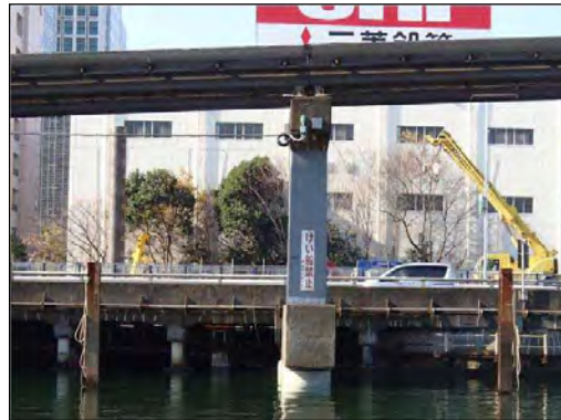
〔支柱耐震補強工事後〕
