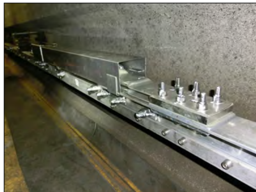
〔本線電車線更新〕
