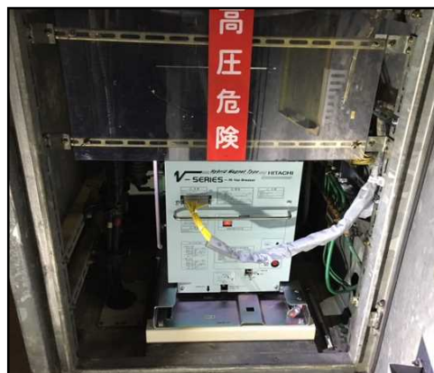
〔配電室遮断器更新〕
