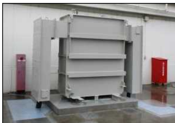
〔高圧配電用変圧器更新〕
