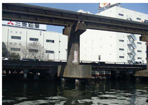
〔支柱耐震補強工事前〕
