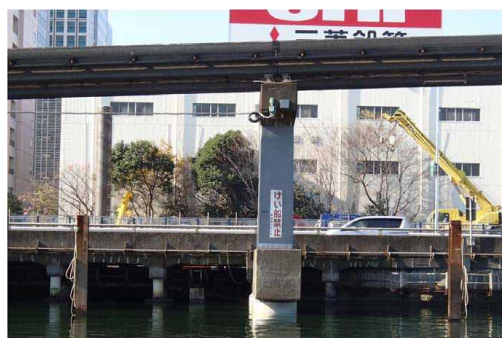
〔支柱耐震補強工事後〕
